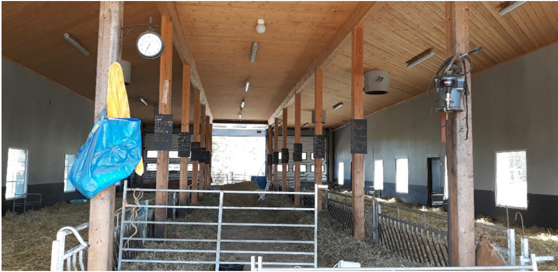
Laudasta tehty sisäkatto
