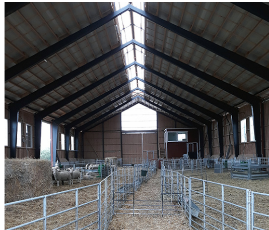
Kattoharjaan voidaan laittaa valokate tuomaan luonnonvaloa.
