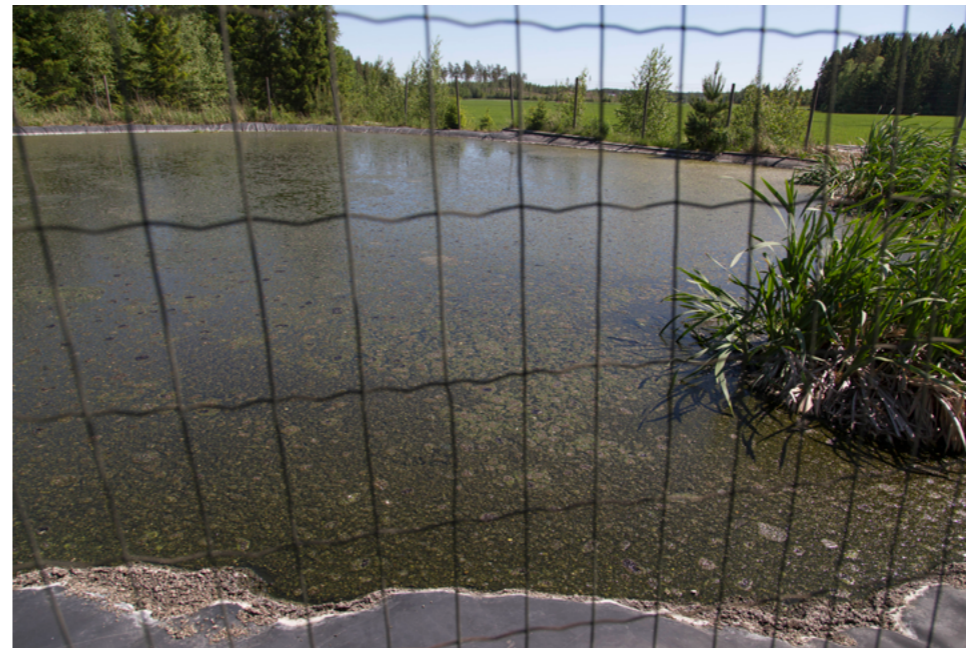
Lietelaguuni on edullinen lietalannan varastoratkaisu. Lietalanta voidaan erillisen kaivon kautta kuormata ilman allaskumin rikkoutumisvaaraa.
