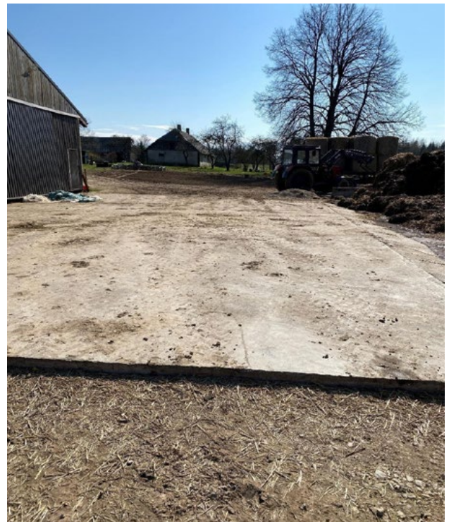
Kuva 5. Viettävä betonipinta toimii hyvin puristenesteen kerääjänä. Kuva: Iveta Grudovska
