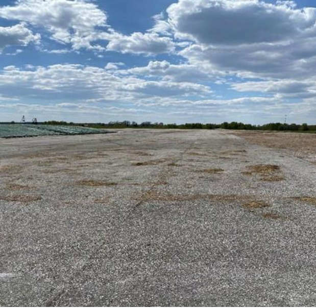
Kuva 1. Säilörehun varastointia entisen lentokentän asfalttipinnalla. Kuva: Iveta Grudovska
