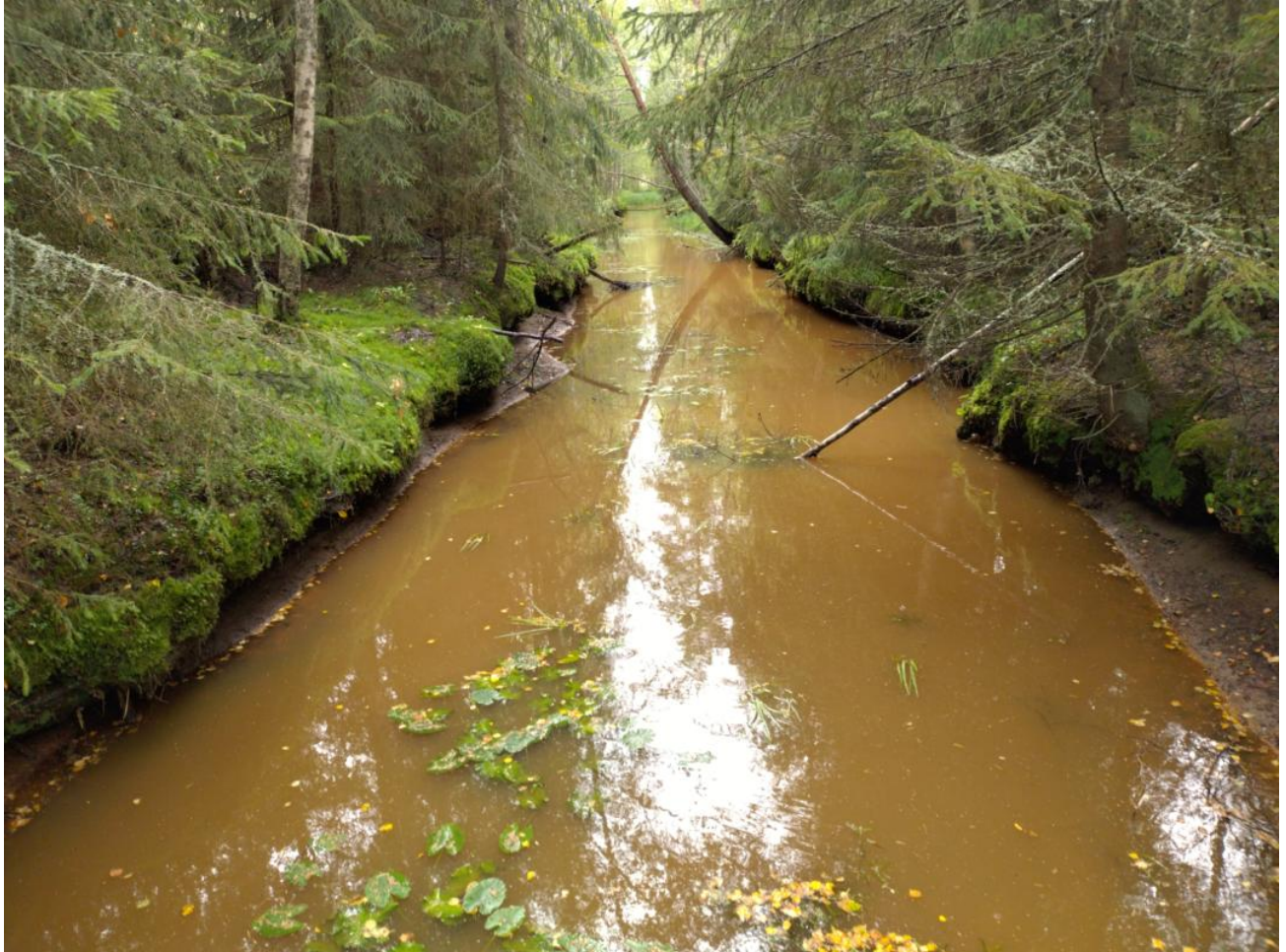
Kuva 21. Selkäkanavan itäpäätä kuvattuna länteen 19.8.2024.
