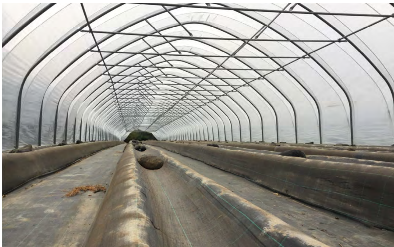
Kuva 20. Tunneleita voidaan valmistaa erilaisiin käyttötarpeisiin. Saksassa on suosituin goottimallin tunneli, jonka korkeus on 4,5 m ja leveys 9,5 m.
